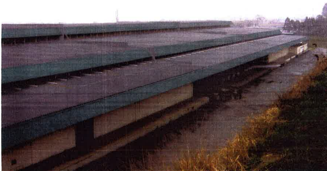
FOTO 15 – Vista da cobertura do Prédio do Depósito, típica para todas as edificações.
